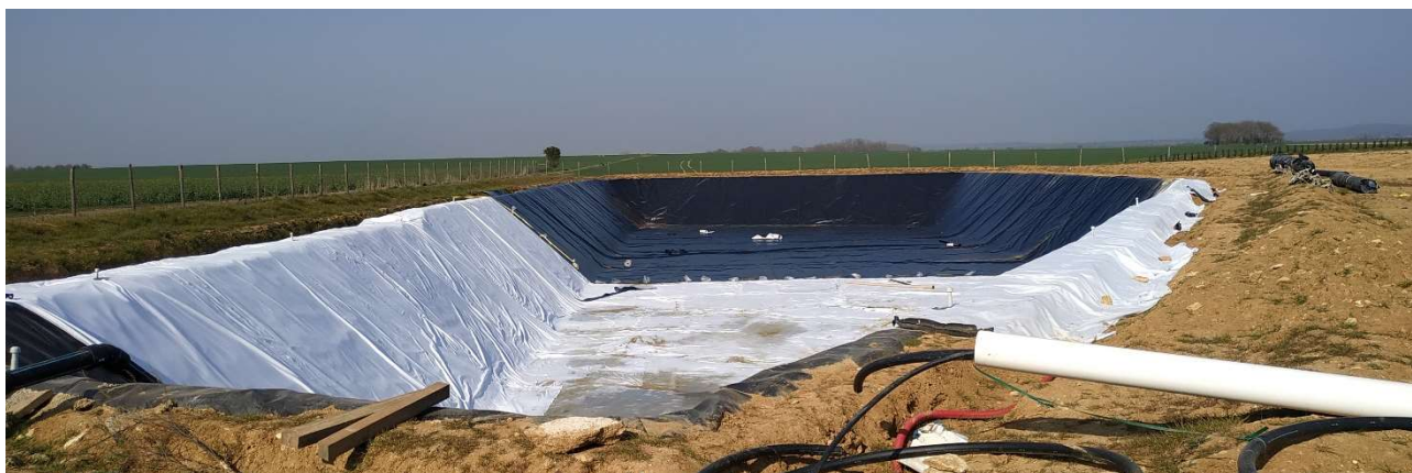
Figure 2 : Travaux d'aménagement de la lagune de 10000m3 sur site
