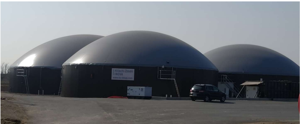
Figure 1 : Digesteurs et Post-digesteur du site DTP Métha
