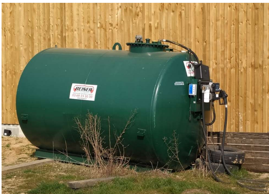
Figure 10 : Cuve à fioul double paroi
