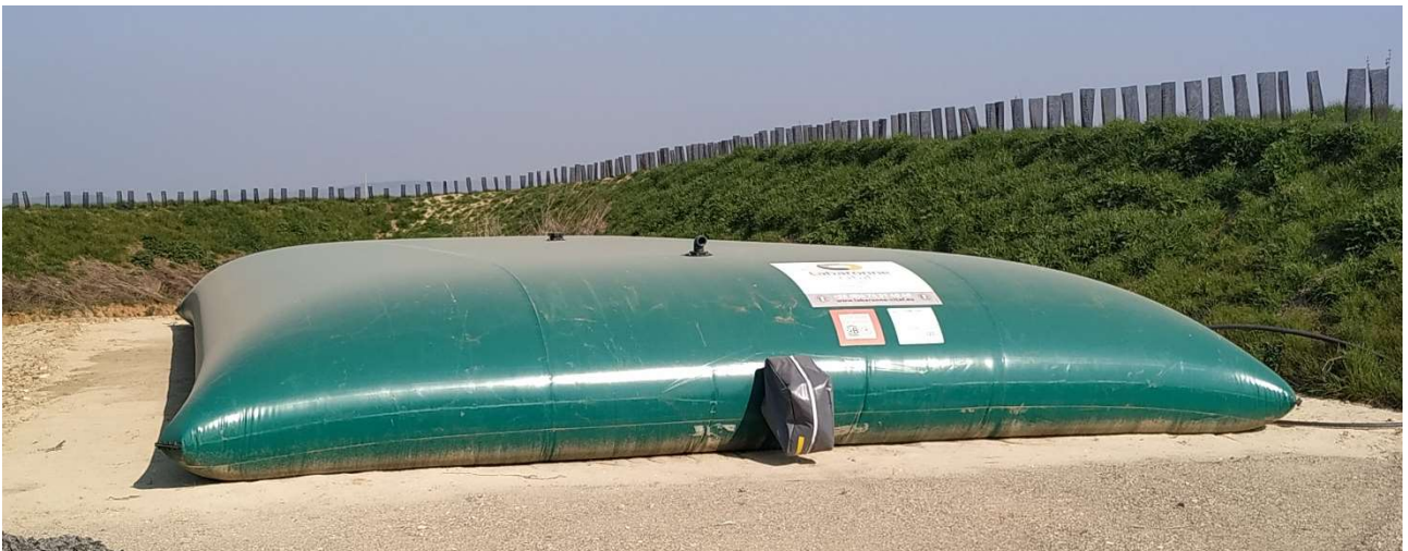
Figure 9 : Réserve à incendie de 120m 3
