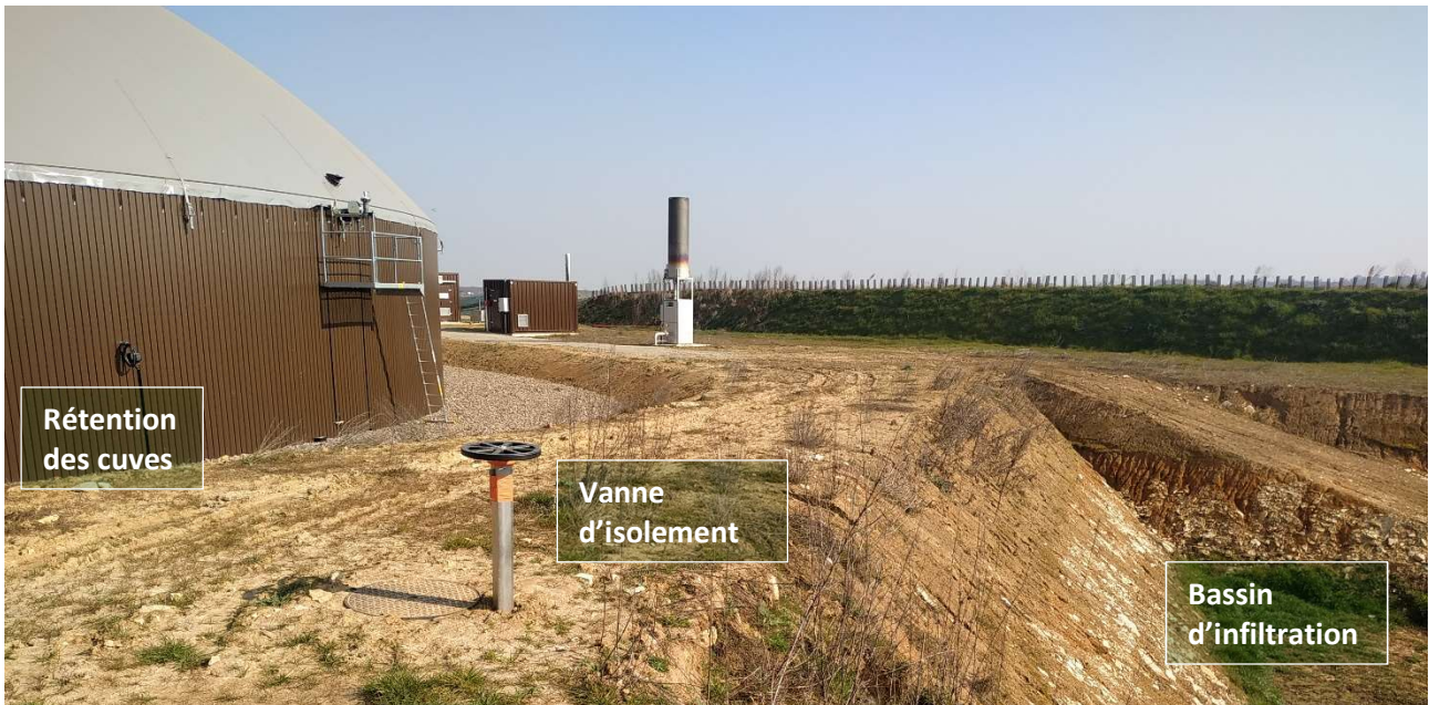
Figure 6 : Schéma de fonctionnement de la zone de rétention
